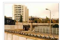
Grenzabschnitt Liesenstraße mit Tunnel unter Sektorengrenze kreuzender S-Bahn-Trasse (1980)
