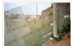
Streckmetallgitterzaun im Grenzbereich Berlin
